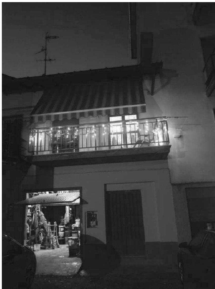
FACCIATA SU CORTE INTEERNA N. 2
